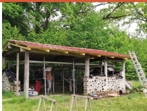
Construction de l'abri du Verger conservatoire.
